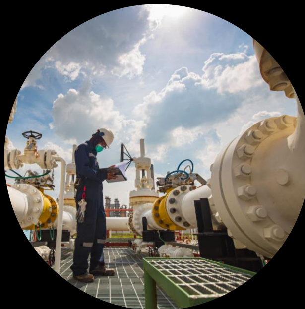
Контроль целостности трубопровода
